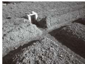
写真①：溝切機による排水溝 写真②：排水口への連結
